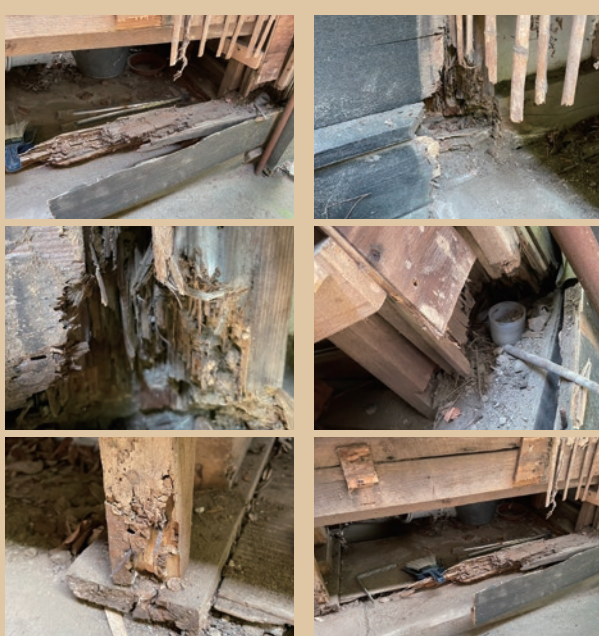
本年5月、鶴島客殿にシロアリの被害が確認され、世田谷区文化財課と銀座化成産業（駆除業者）との調査を終え、部分補修とシロアリ対策を講ずることにしました。
